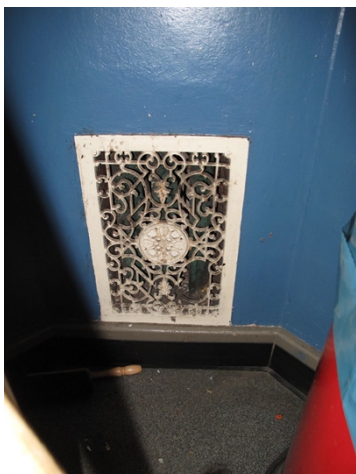
Afsluiting ventilatieopening
